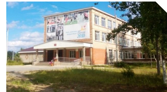
выполнение работ по устройству бетонного основания спортивной площадки в МБОУ «Игримская СОШ № 1».
