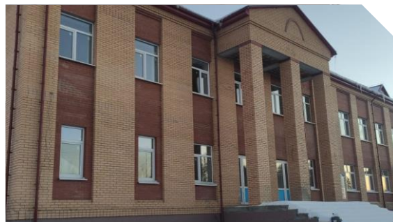
завершение строительства объекта «Образовательно-культурный комплекс в с. Хулимсунт»,
