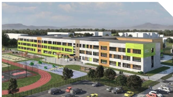
строительство объекта «Средняя образовательная школа в пгт. Березово»
