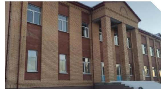
Завершение этапа строительства «Образовательно-культурный комплекс в с. Хулимсунт»,
